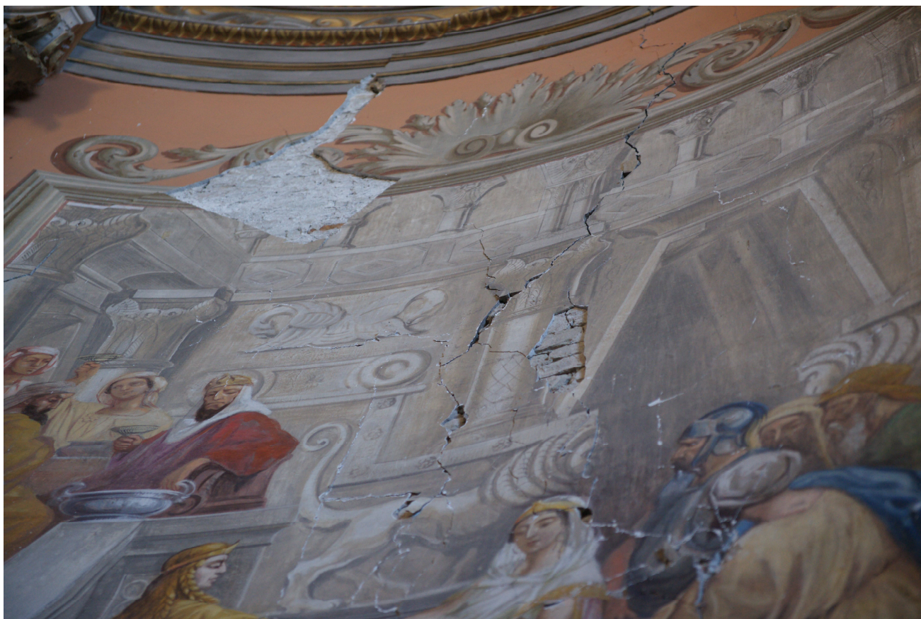
Parete abside, part. zona di destra. Diffuse cadute di intonaco e fessurazioni.
