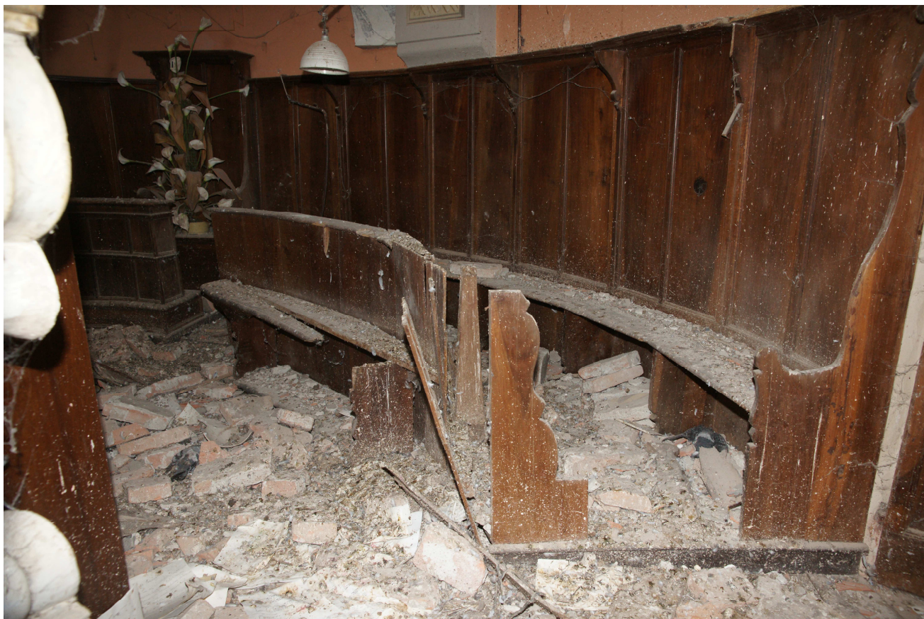
Presbiterio / abside, coro ligneo. Danni da caduta di mattoni e calcinacci, a terra anche accumulo di guano.
