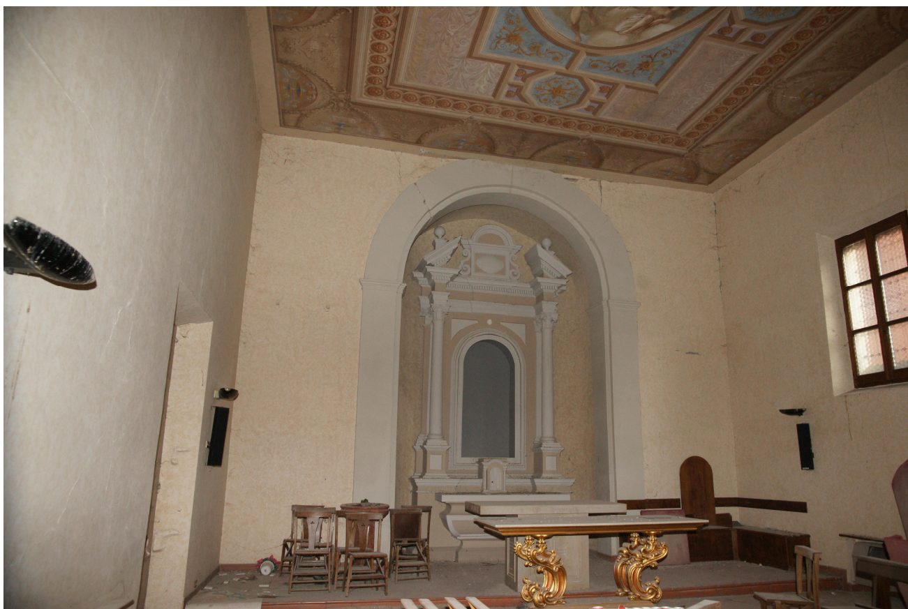
Cappella. Soffitto decorato su incannucciato, fessurazioni e modeste cadute di colore. Le pareti, coloritura moderna, hanno fessurazioni moderate, di cui le più gravi nella parete dell'ancona muraria e in stucco.
